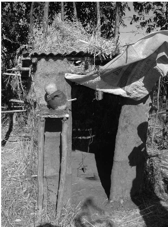
Voici un exemple de latrines construites en Ethiopie.
